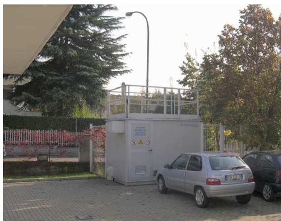
Stazione di rilevamento in S. d'Acquisto - Asti
