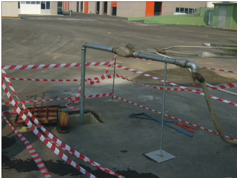
Installazione della condotta provvisoria per la prova a gradini
